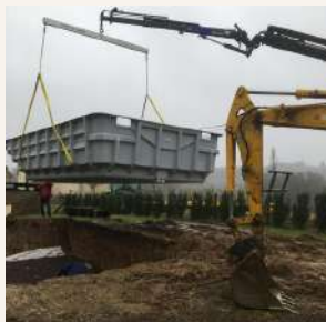
2. Livraison et pose de la piscine
