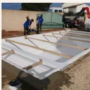
5. Création de l'assise béton
