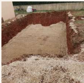
1. Terrassement et excavation de la surface de la terre
