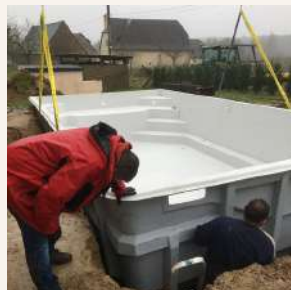
3. Mise à niveau
