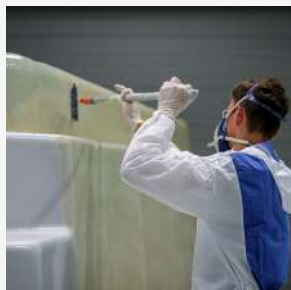
3. Application d'un tissu en fibre de verre anti-corrosion
